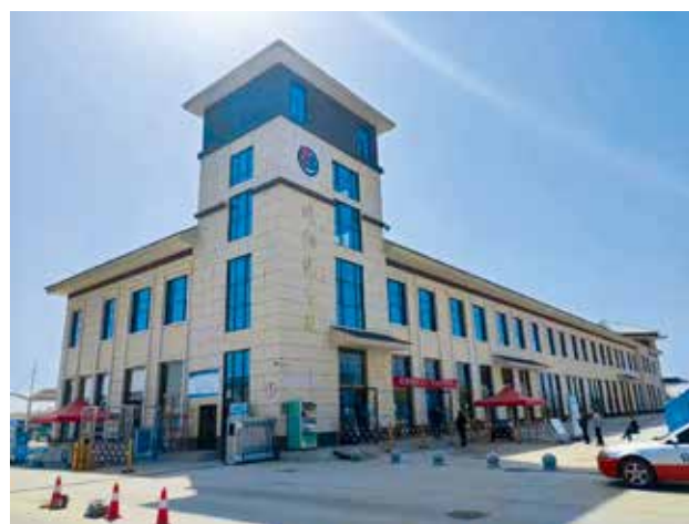
凤翔客运站（省道路运输中心）
