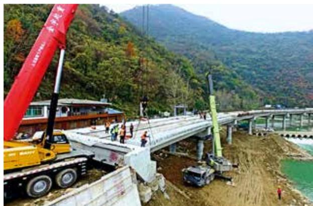
2022年11月20日，244国道留坝姜窝子水毁应急修复改线工程最后一块梁架设计完毕，标志着该工程取得突破性进展，为12月底实现全线贯通奠定坚实基础（汉中市公路局）
