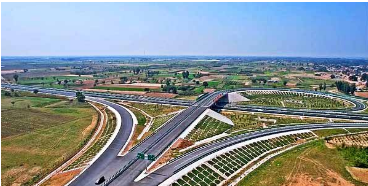
S13 澄商高速澄韦段澄城出口互通立交（渭南市交通运输局）
