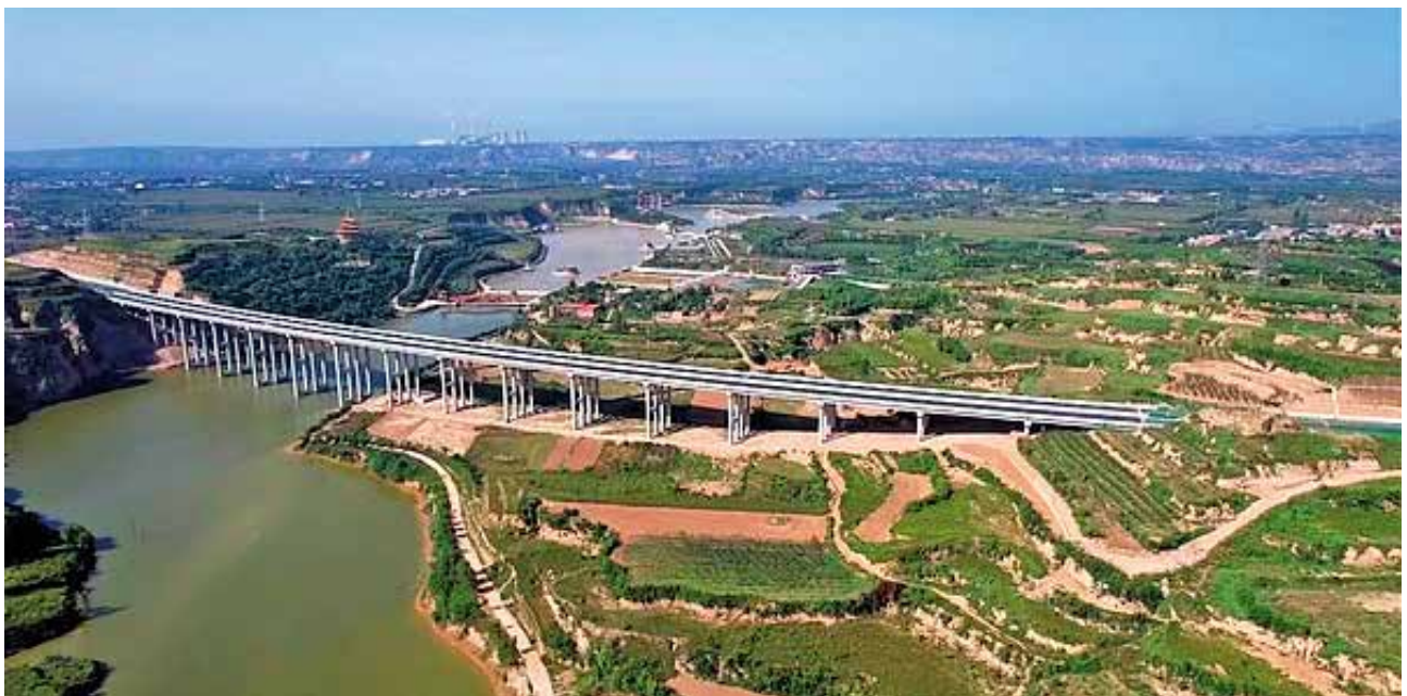
S13 澄商高速澄韦段大峪河特大桥 (渭南市交通运输局)
