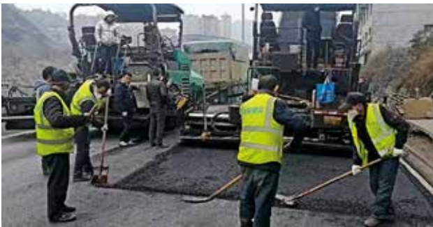
2022 年 12 月 13 日，安康市 2022 年度重点民生票决项目—541 国道汉王至洞河公路改建工程实现路面贯通（安康市交通运输局）
