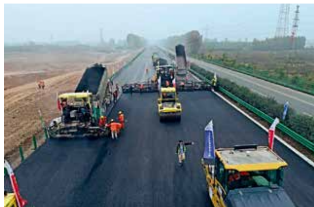
2022 年 11 月 1 日,随着京昆高速涝峪立交至涝峪安检站 2.5 公里主线贯通,京昆改扩建项目南段(河池寨枢纽立交至涝峪互通立交)全面进入沥青中面层大面积施工新阶段 (京昆改扩建管理处)
