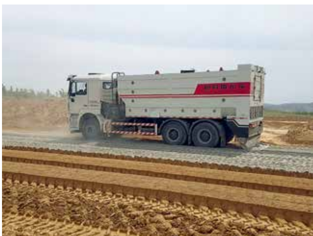
水泥稳定风积沙施工
