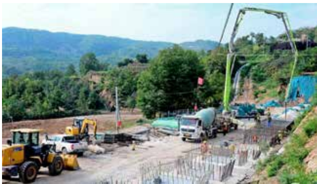
2022年11月15日，2021年度全省最大公路水毁修复工程项目312国道永寿永平重大水毁修复工程，经过6个多月的加紧抢修，已全面恢复通行 (咸阳市公路局)
