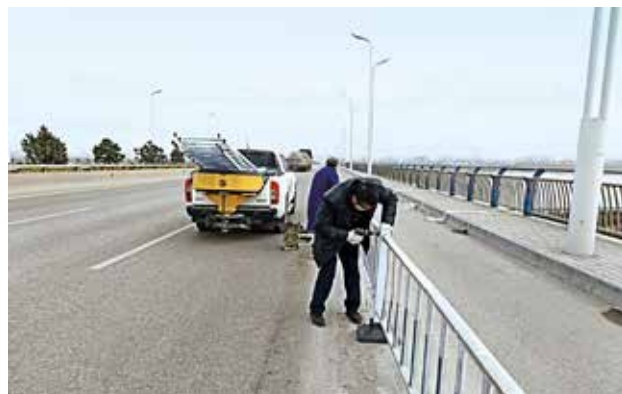
2022 年，杨凌示范区维修渭河大桥护栏
