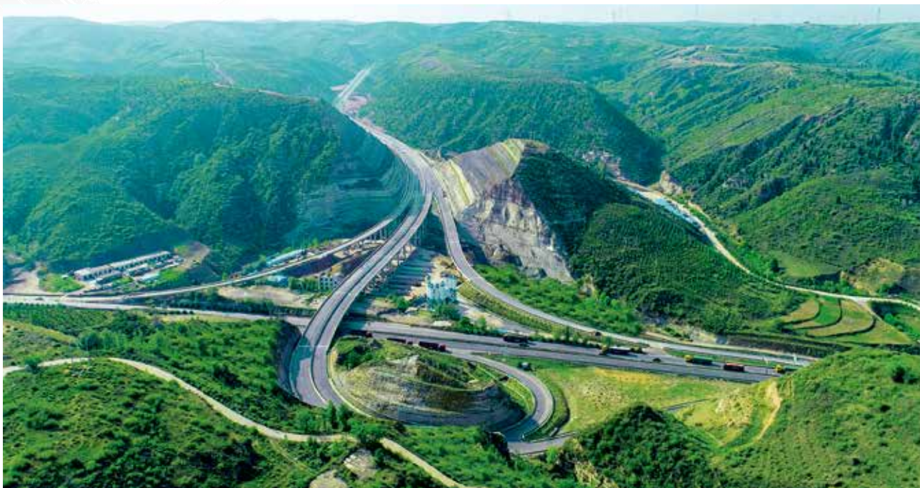
2022年，建成的336国道神木店塔至张板崖东过境公路（榆林市交通运输局）
