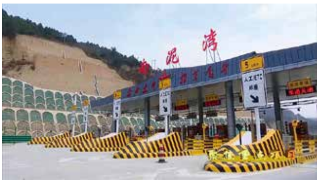
2022 年 10 月 31 日，延西高速南泥湾立交及收费站改扩建项目正式建成通车（延安市交通运输局）
