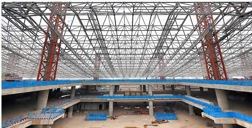
2022年12月，西安咸阳国际机场三期扩建工程东航站楼施工现场 (西部机场集团)
