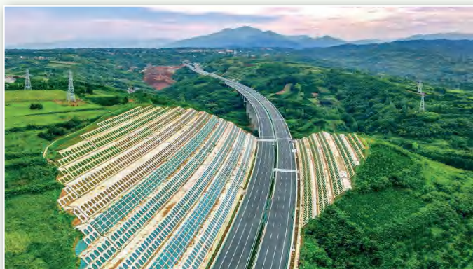
S02西安外环高速沪河特大桥段
