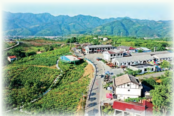
商洛市商州区麻漫公路
