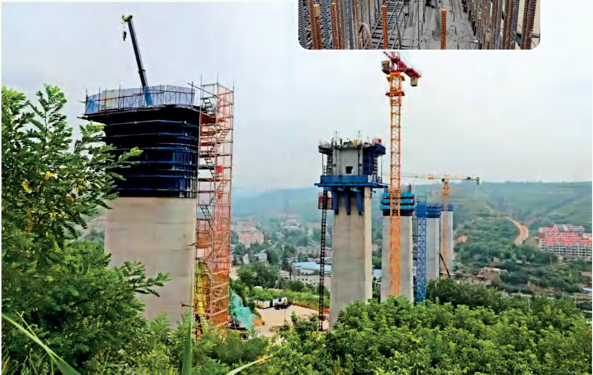
王家河特大桥主墩建设现场（中铁西安局集团）
