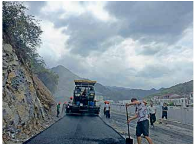
2022年9月20日,镇坪县交通运输局养护人员实施钟宝镇小学联网路沥青铺设
