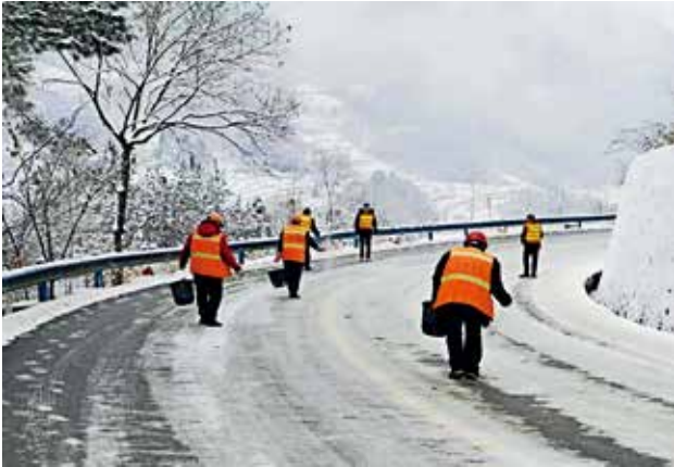
2022年2月7日,岚皋县交通运输局组织养护人员对541国道结冰路段撒融雪剂 (刘翔)
