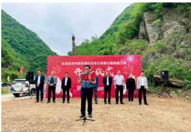
2022 年 5 月 12 日，汉滨区举行东镇至三县堡公路改建工程开工仪式 (鹿博)
