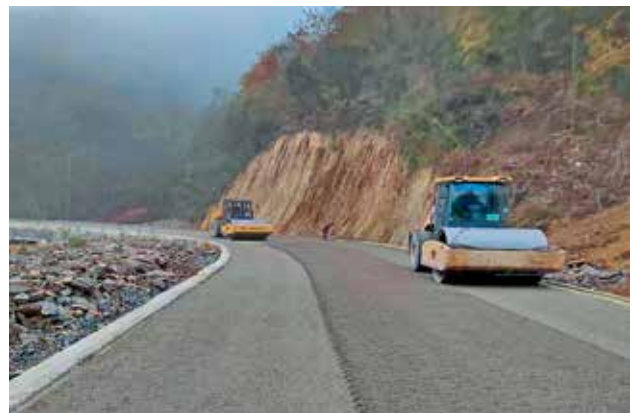
2022年10月22日，紫阳县交通运输局在擂鼓台旅游路铺设水稳层
