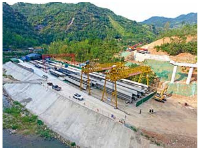
2022年9月21日，洋县交通运输局设在金水镇大地村的108国道金水过境段桥梁梁板预制场
