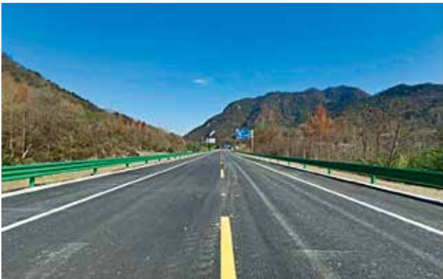
2022年11月19日，略阳县345国道改建郭镇段完工 (付建菲)
