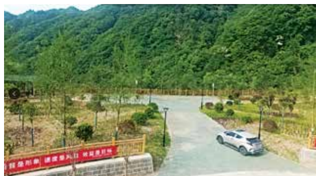
2022 年，佛坪县银金路景观绿化及停车坪一角
