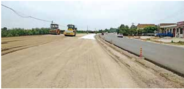
2022年5月，108国道韦庄至蒲城公路工程蒲城段施工现场 (张 伟)
