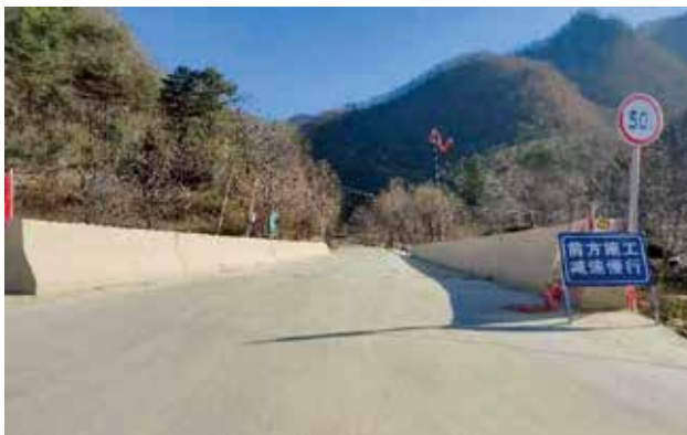
2022 年 9 月 22 日, 华州区任家滩桥路面整修项目 (张鑫)
