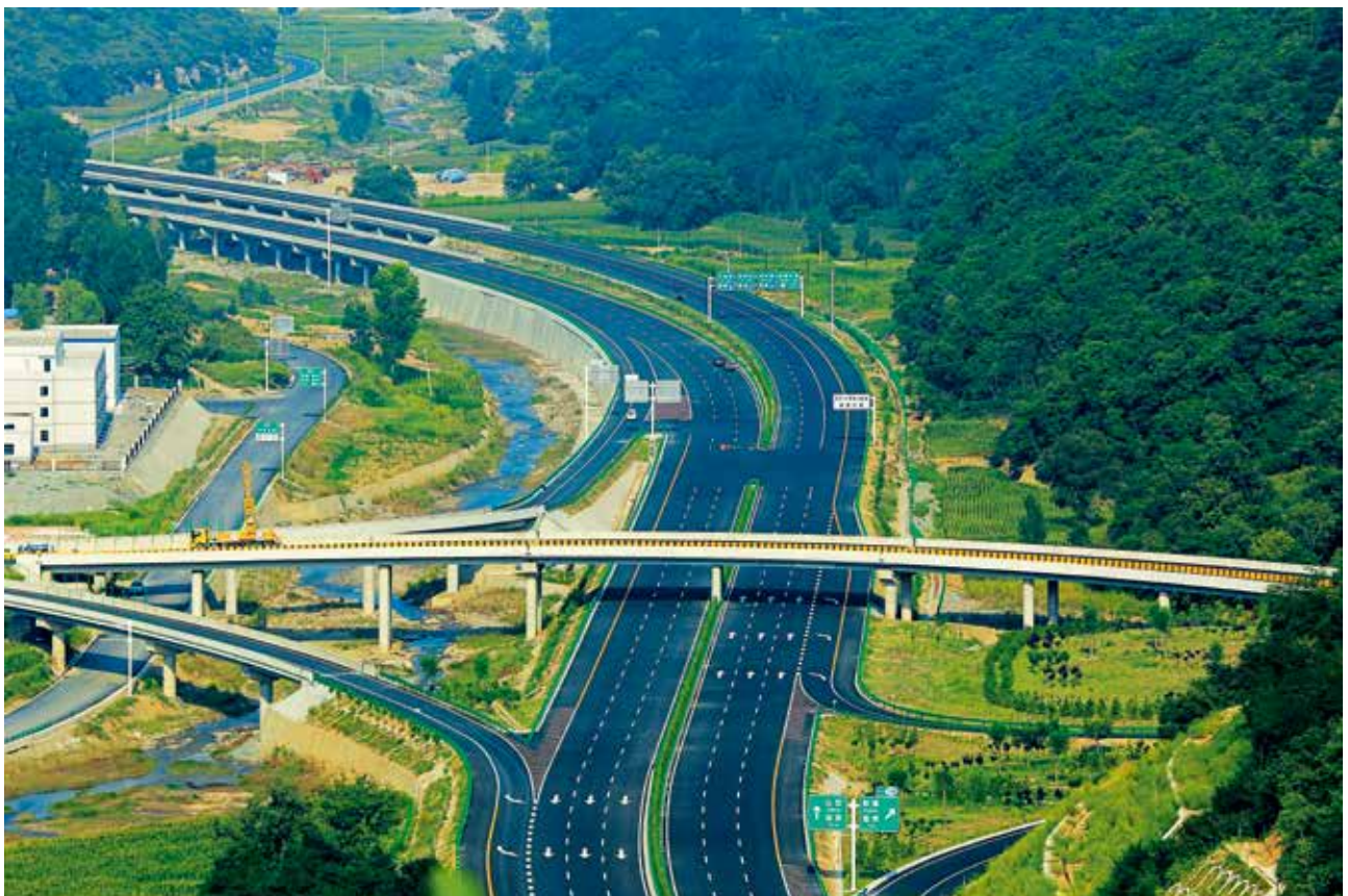
2022年,俯瞰宜君县内延西高速互通式立交
