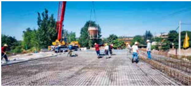
2022年8月5日，耀州区药王山连接线道路施工现场 (余伟)
