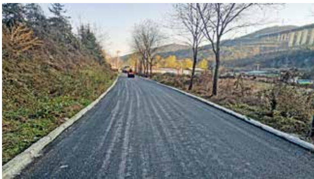
2022年，王益区常家河村至白家河村道路改造项目全面完成
