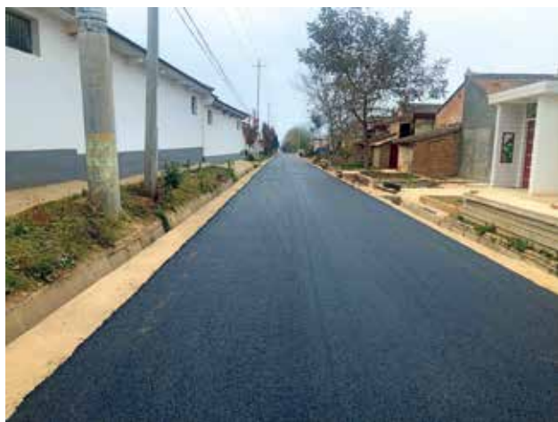
2022年9月26日,旬邑县交通运输局在吕家村进行通村路沥青路面铺设
