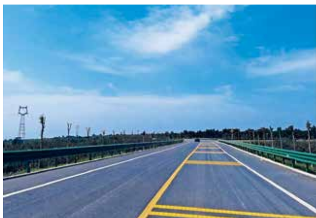
2022年，乾县交通运输局升等改造工程南环路（南坊至阳洪）建成通车
