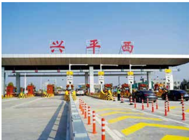
2022年10月，西宝高速公路兴平西立交工程按期完工，兴平西出口开通运营
