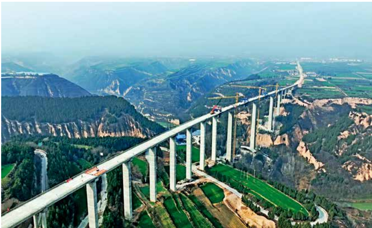
2022年11月21日，永寿县马坊沟大桥合龙现场
