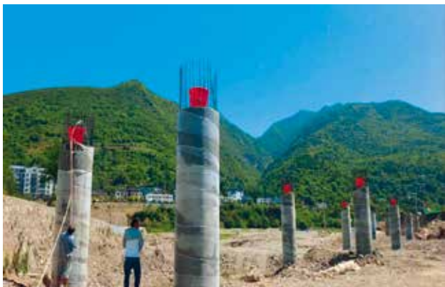
2022 年 6 月 10 日，242 国道山阳县马滩、板岩、宽坪过境公路改建工程马滩段 1 号桥施工现场 (赵 丹)
