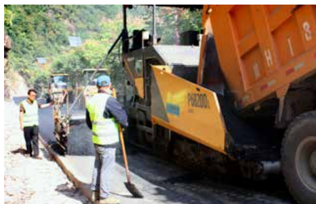
2022年10月,商南县交通运输局在清油河镇后湾村进行清腰路1期项目建设的沥青路面摊铺
