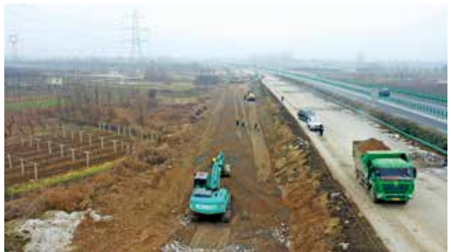
2022年12月，京昆高速“四改八”鄠邑段施工现场 （李敏）
