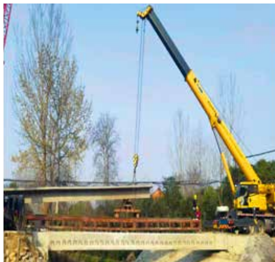
2022年3月22日，周至县涉农整合资金危桥改造项目渭中村2号桥梁架梁设
