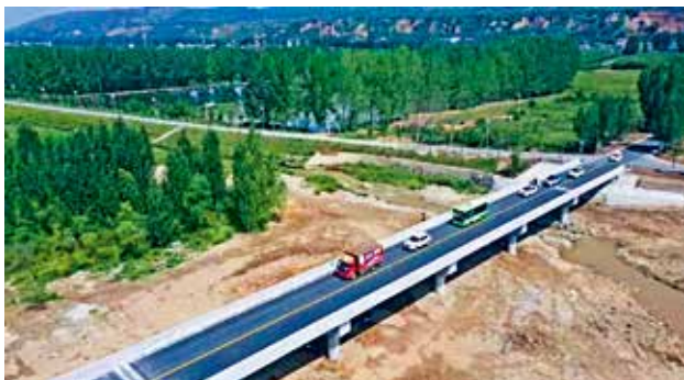
2022 年 8 月 31 日，长安区半引路团结桥竣工通车
