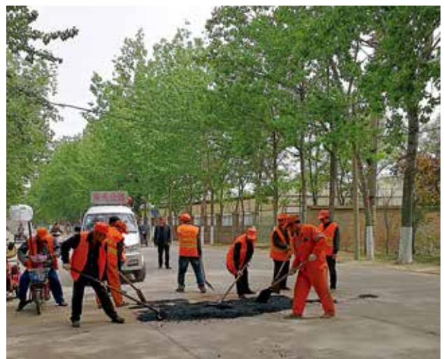
2022年4月，未央区交通运输局在丰景路进行日常养护
