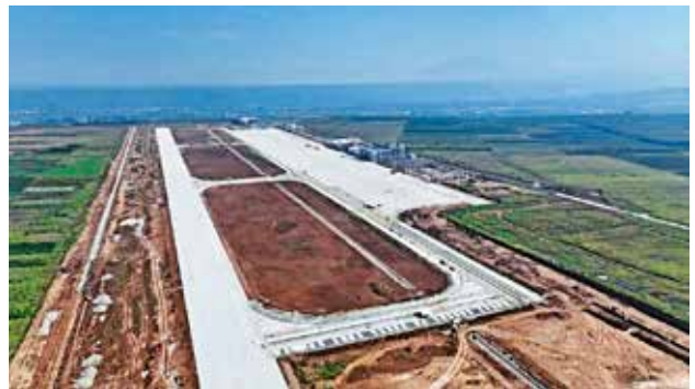
2022年，蓝田通用机场建设现场
