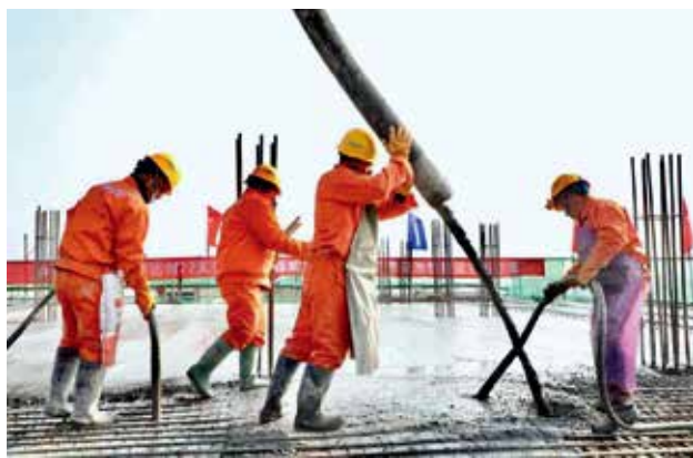
2022年11月17日上午，西安地铁10号线榆楚西站主体结构顺利封顶。至此，地铁10号线17座车站全部封顶，该工程进入附属结构施工阶段 (西安轨道集团)
