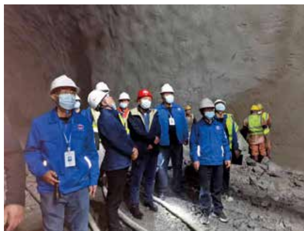
2022年5月，西安铁路监督管理局检查秦岭马白山隧道施工现场 (西安铁路监督管理局)
