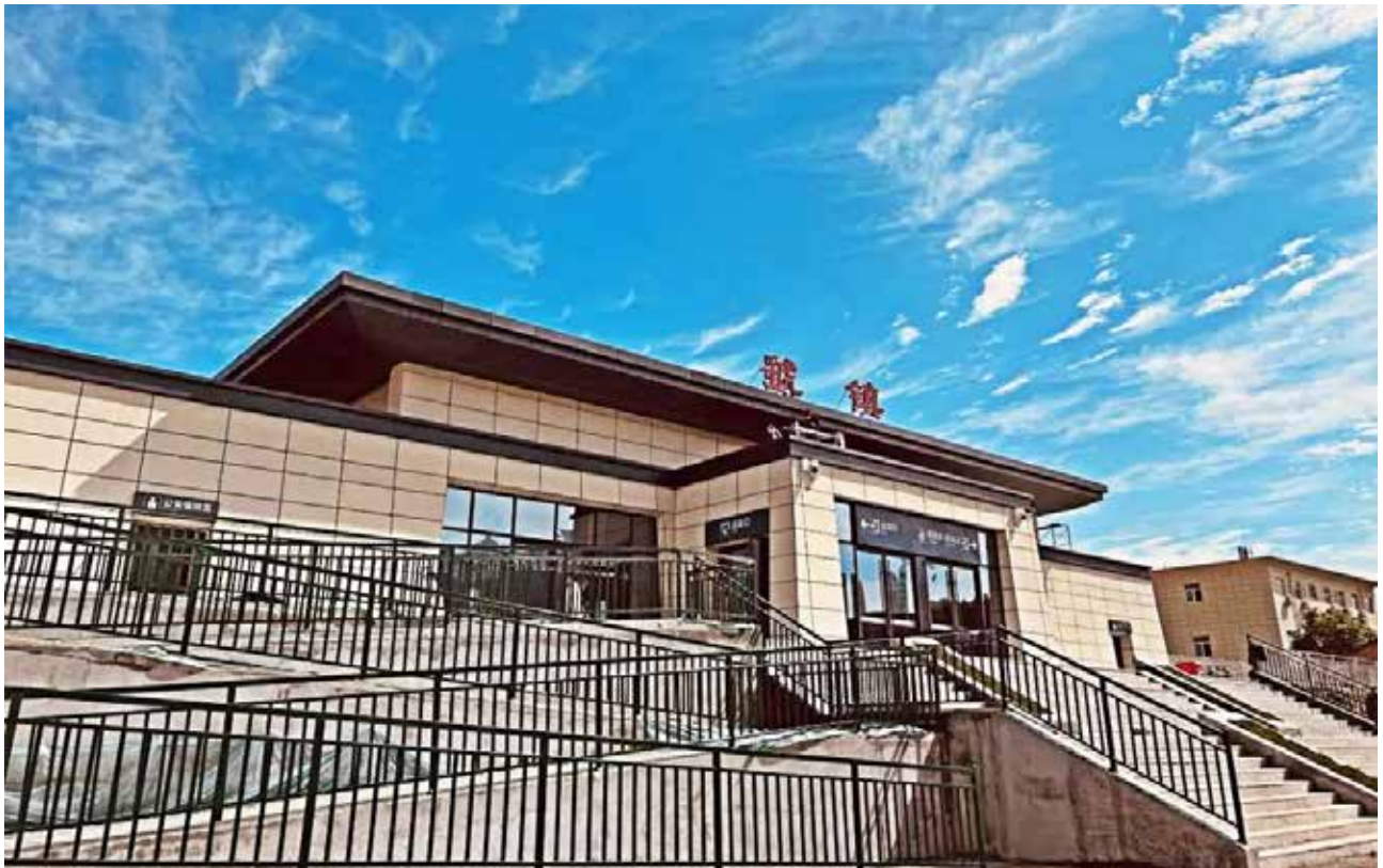
2022年6月10日，中铁西安局集团启动骛镇站改扩建工程，将新建约650平方米，集售票、服务、问询等为一体，最多可容纳500余名旅客的候车厅 (中铁西安局集团)
