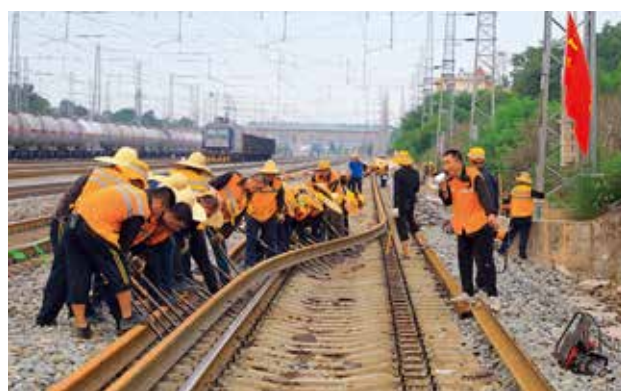
2022 年 8 月 18 日，陇海线窑村站股道升级施工
