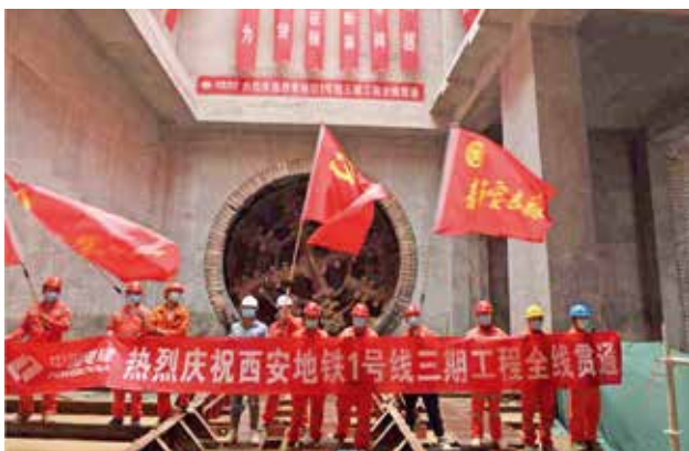
2022年9月2日上午，随着秦都站—宝泉路站区间左线顺利贯通，至此西安地铁1号线三期工程实现全线“洞通”，为后续工作的顺利实施奠定基础 (西安轨道集团)
