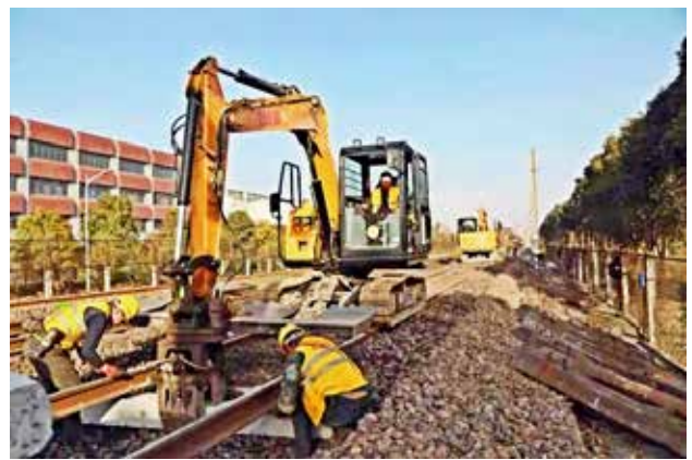
2022年4月，包西线集中修施工现场 (中铁西安局集团)
