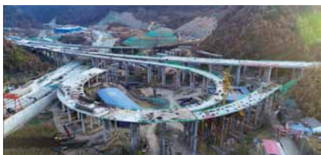
2018 年 12 月 12 日，建设中的太（白）凤（县）高速公路田坝枢纽立交桥（省高速集团）
