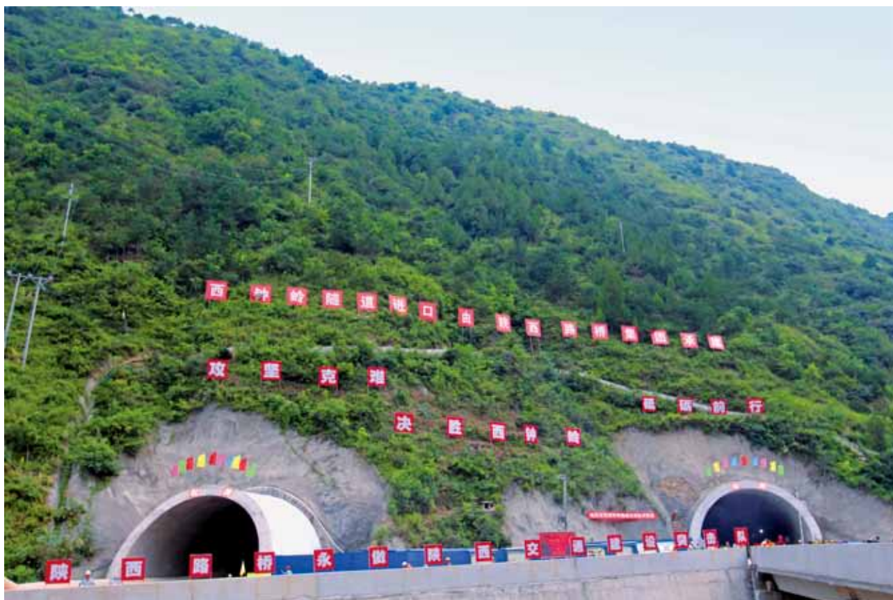
柞水至山阳高速公路西钟岭隧道建成 2018年8月3日摄（陕西路桥集团）
