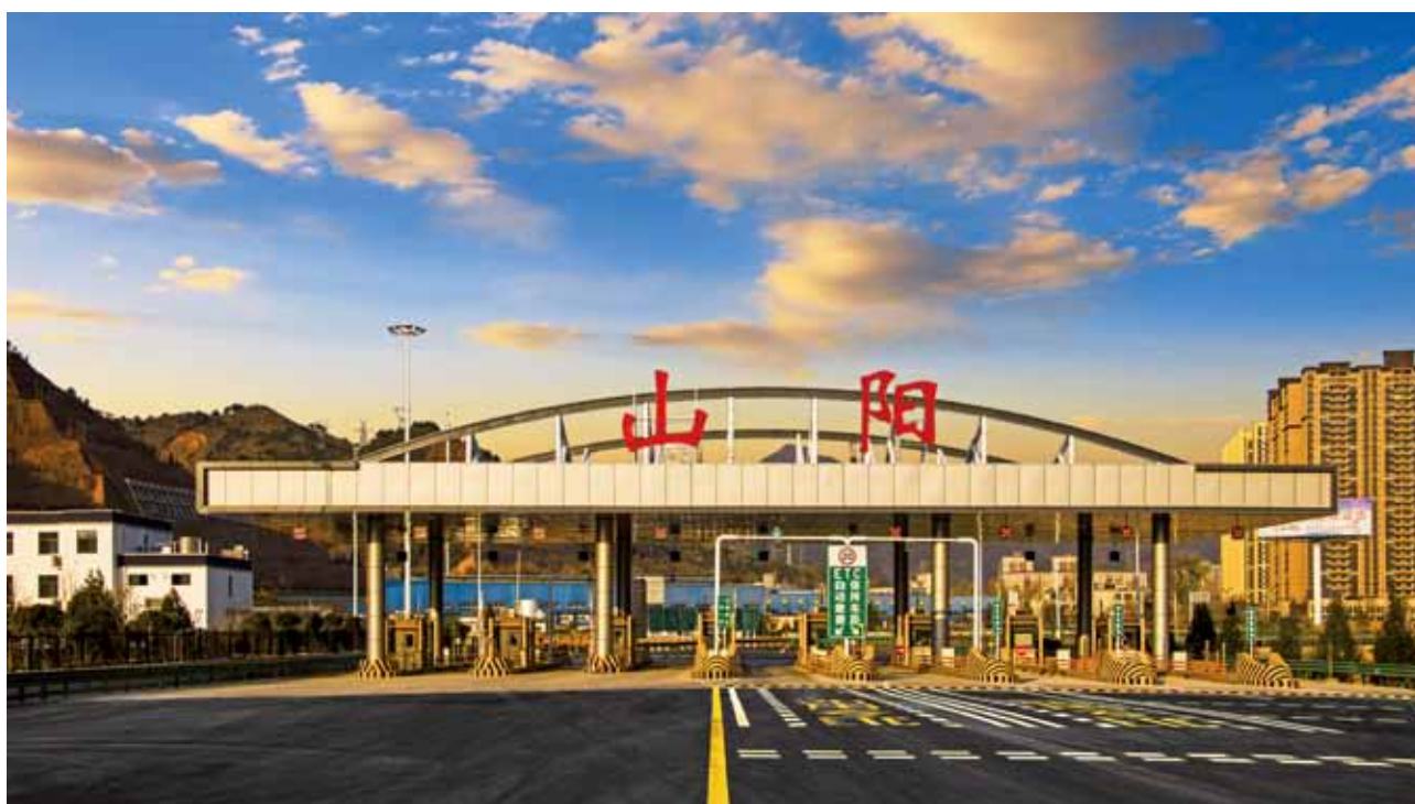
2018 年 11 月 3 日，新建成的柞水至山阳高速公路山阳收费站（省交通集团）
