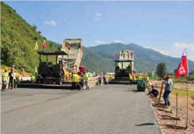
2018年8月29日，太凤高速公路建设项目水泥稳定碎石底基层试验段在TF-01合同段施工现场 (年鉴编辑部)
