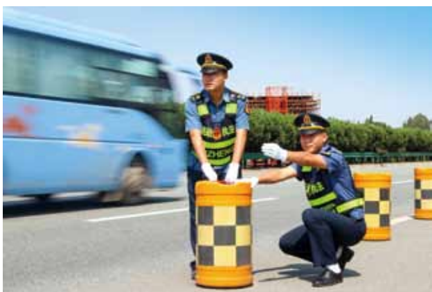
2018年9月11日，西临路政中队路政人员在西（安）临（潼）高速公路摆放隔离墩（省高速集团）
