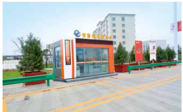
2018年，省交通集团在西咸北环高速公路大王收费站建成智慧便民服务亭（省交通集团）
