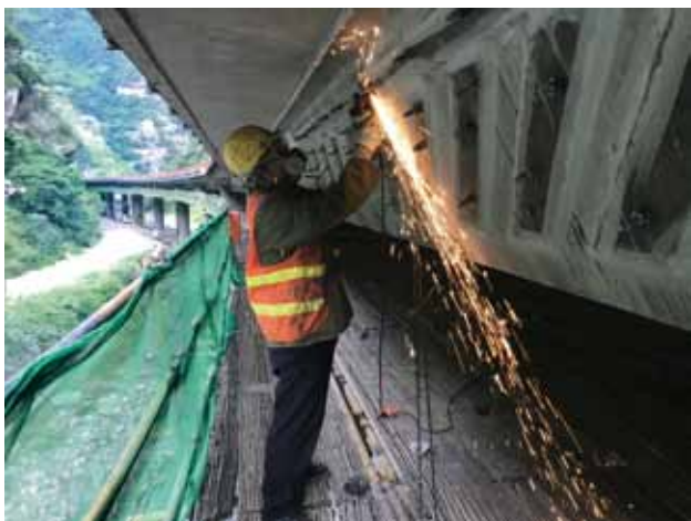
2018年6月15日，西（安）汉（中）高速公路桥梁维修工人加固桥梁钢板 (省高速集团)
