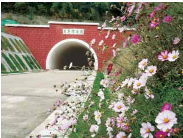
2018年6月10日，212省道月亮湾隧道全线安全贯通 (屈凤爱)
