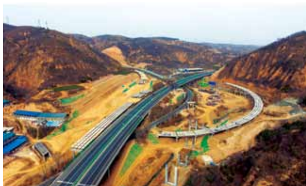
绥延高速公路枢纽互通立交施工（丁亚卫）
