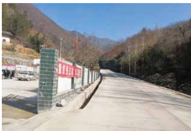
2018 年，佛坪县交通运输局扶贫道路改建工程——银金路建成通车
