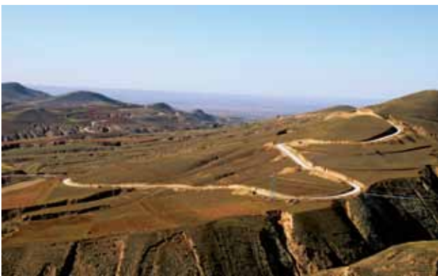
2018年，定边县建成通村水泥路
