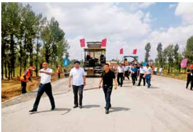
2018年8月14日，靖边县县委书记与全委会参会人员到榆靖公路（靖边段）施工现场进行调研
