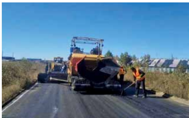
2018年10月，榆阳区长可路铺设油面施工现场
