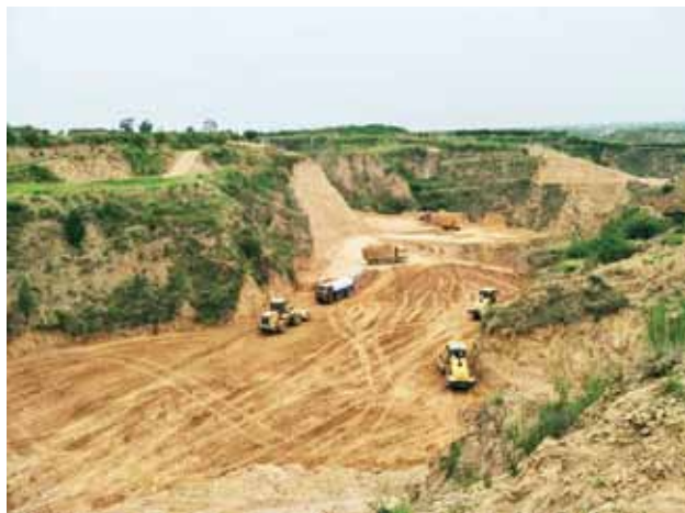
2018年, 342国道澄城段施工现场
