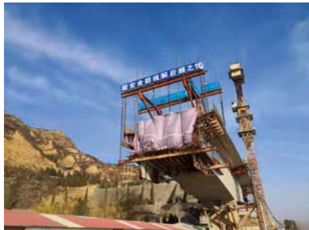
2018 年，合阳县东雷大桥建设现场
