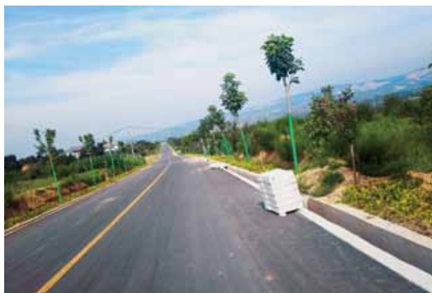
2018年7月19日，王益区黄环旅游公路项目道路绿化施工现场
