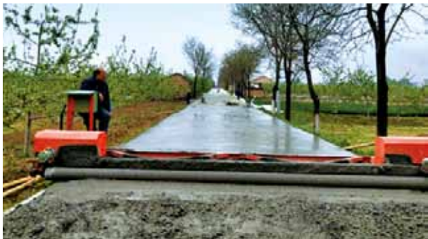
2018年，旬邑县通村通组公路项目施工现场
