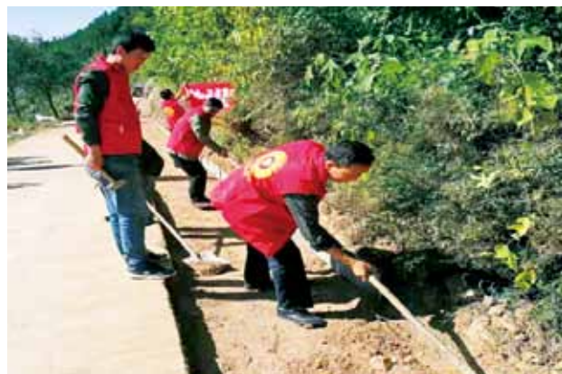
2018年，陈仓区交通运输局举行“爱我家园我当一天养路工”主题活动。图为培植路肩养护作业现场
