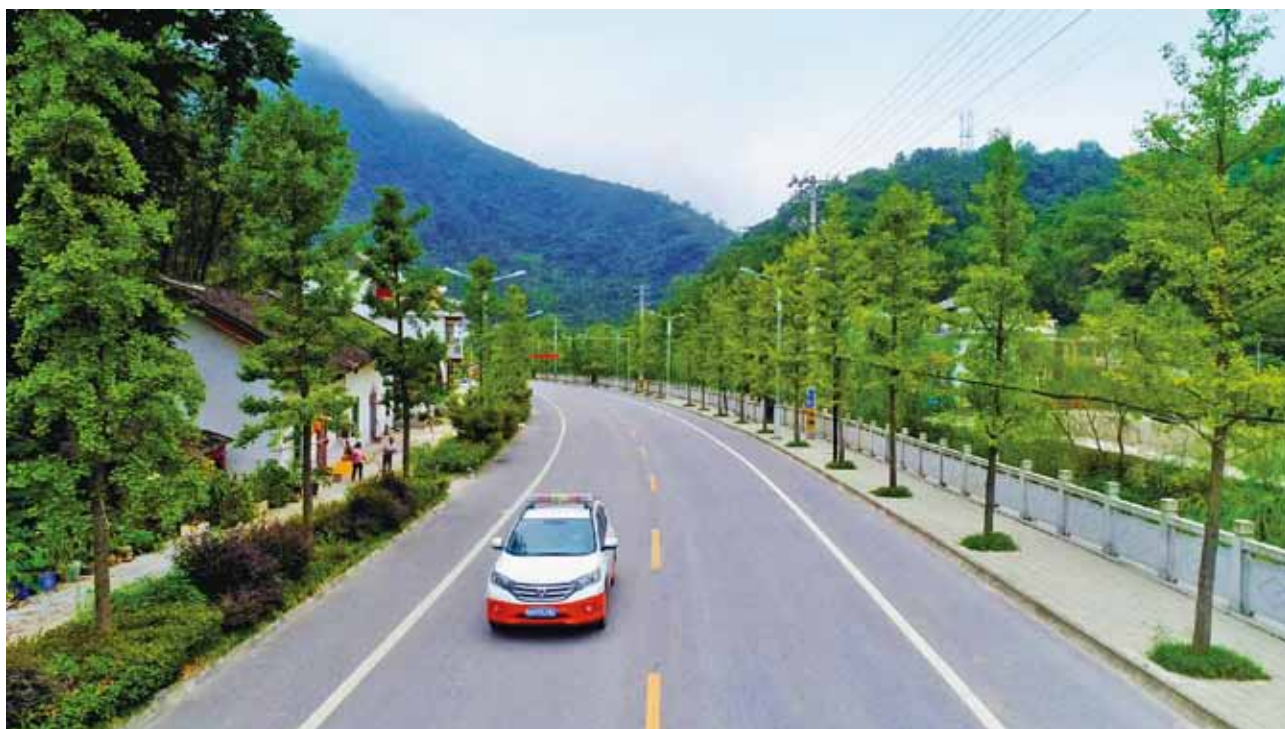
2018 年 4 月，新建绿化、安装路灯等附属设施后的 345 国道镇安路段（张磊）
