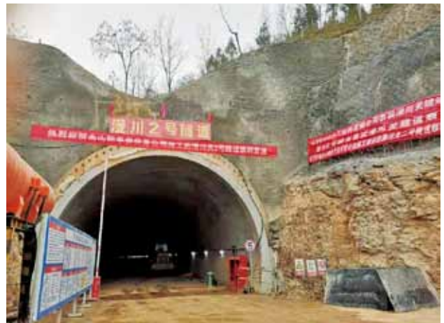
2018年，山阳县漫川关2号隧道顺利贯通
