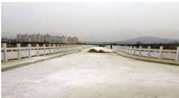
2018年,丹凤县交通运输局建成的南沟口丹江大桥
