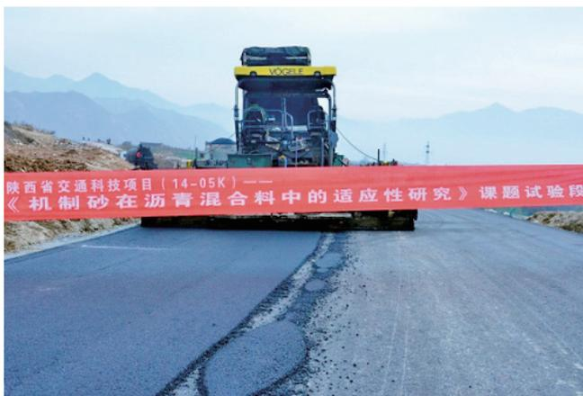
2015年，省交通科技项目《机制砂在沥青混合料中的适应性研究》课题组进行现场试验
